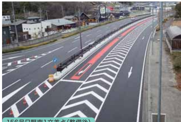
156号日野南1交差点(整備後)
