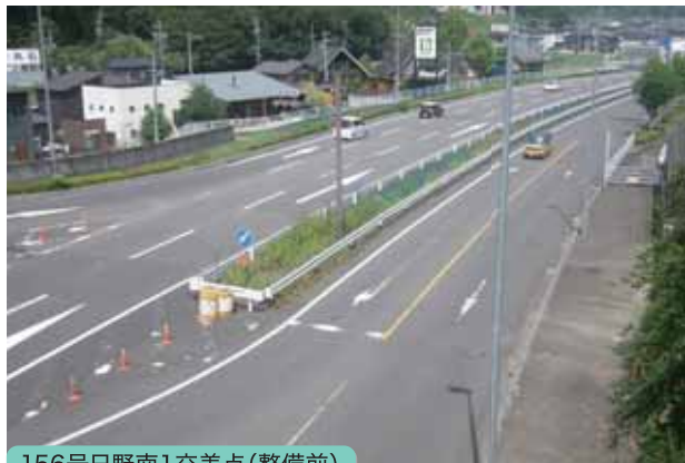
156号日野南1交差点(整備前)
