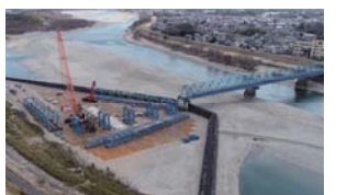
被災橋梁撤去工事の状況
