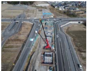
改良工事の状況
