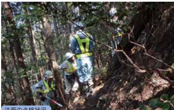
法面の点検状況
