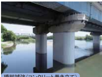
橋脚補強(コンクリート巻き立て)
