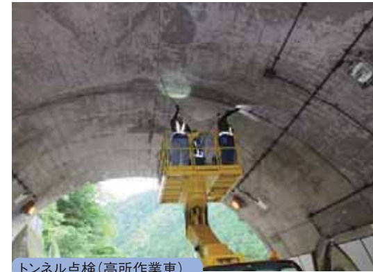
トンネル点検(高所作業車)
