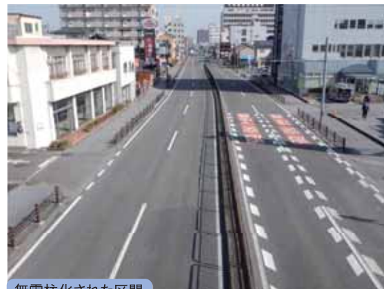
無電柱化された区間
