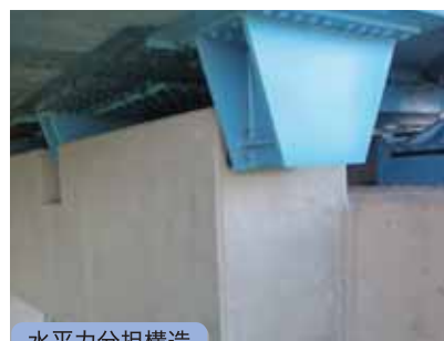
水平力分担構造
