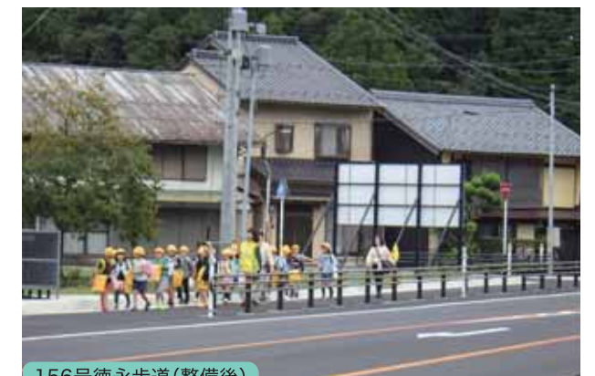
156号徳永歩道(整備後)
