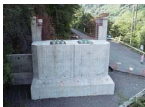
下部工工事の状況
