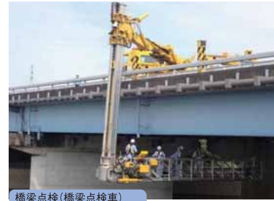
橋梁点検(橋梁点検車)
