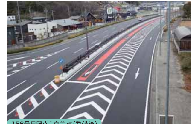
156号日野南1交差点(整備後)
