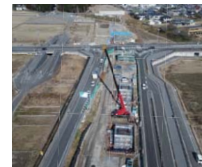
改良工事の状況
