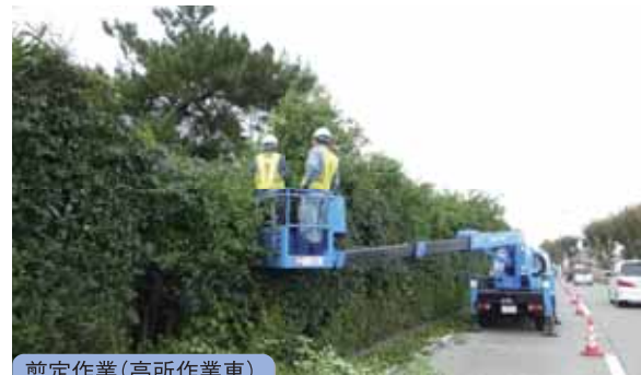
剪定作業(高所作業車)
