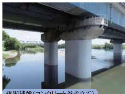
橋脚補強(コンクリート巻き立て)
