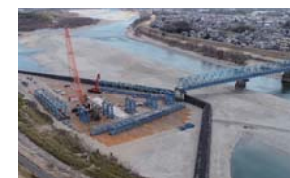
被災橋梁撤去工事の状況
