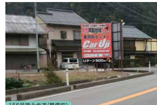
156号徳永歩道(整備前)
