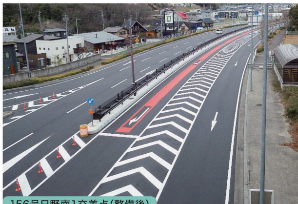
156号日野南1交差点(整備後)
