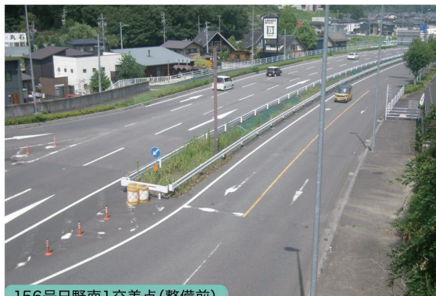
156号日野南1交差点(整備前)
