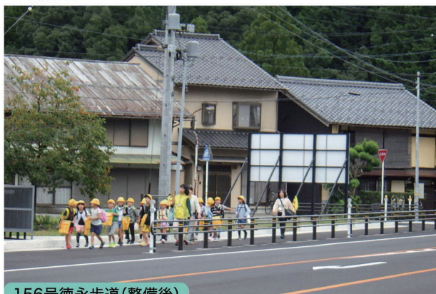
156号徳永歩道(整備後)
