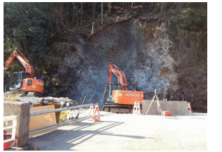
下部工工事へ着手
