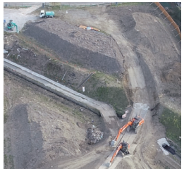
改良工事へ着手
