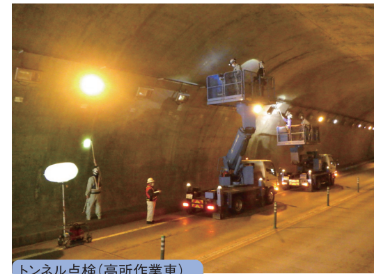
トンネル点検(高所作業車)
