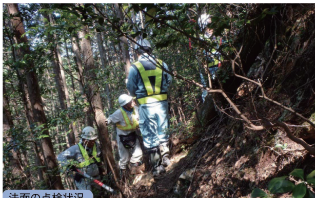
法面の点検状況
