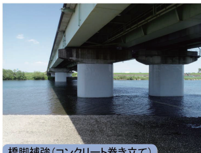
橋脚補強(コンクリート巻き立て)
