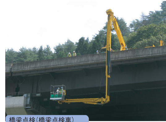
橋梁点検(橋梁点検車)
