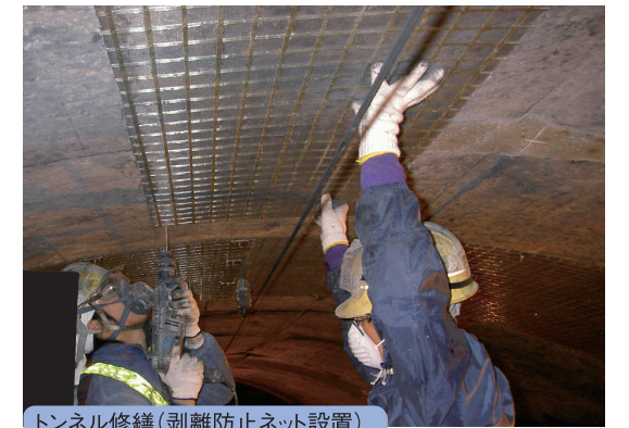
トンネル修繕(剥離防止ネット設置)
