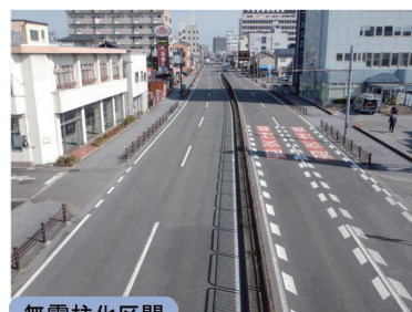
無電柱化区間
