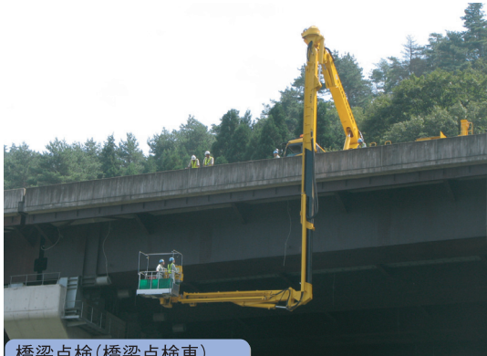
橋梁点検(橋梁点検車)
