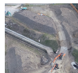
改良工事へ着手
