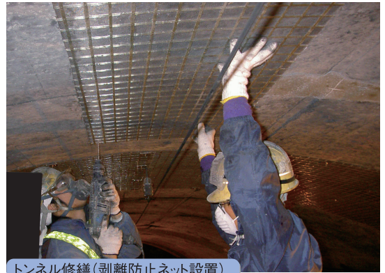
トンネル修繕(剥離防止ネット設置)
