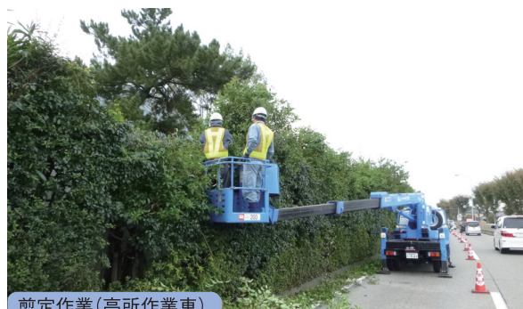
剪定作業(高所作業車)
