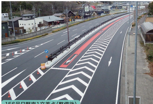
156号日野南1交差点(整備後)
