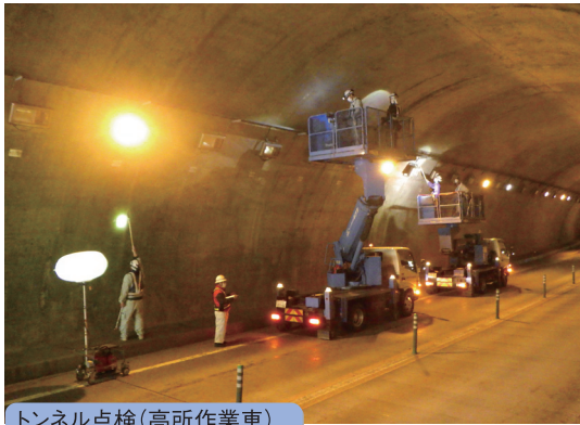
トンネル点検(高所作業車)
