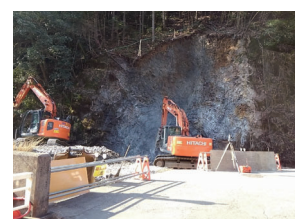
下部工工事へ着手
