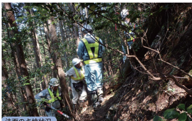
法面の点検状況
