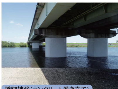
橋脚補強(コンクリート巻き立て)
