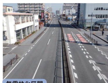
無電柱化区間
