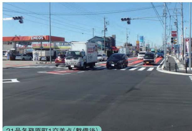
21号各務原町1交差点(整備後)
