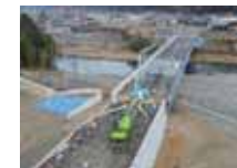
中津屋橋上部工を架けた様子
