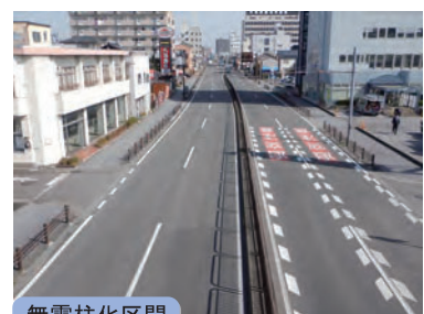
無電柱化区間
