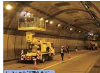
トンネル点検(高所作業車)
