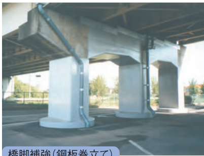
橋脚補強(鋼板巻立て)
