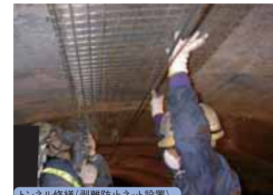
トンネル修繕(剥離防止ネット設置)
