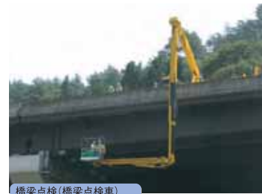
橋梁点検(橋梁点検車)
