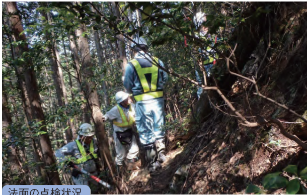
法面の点検状況
