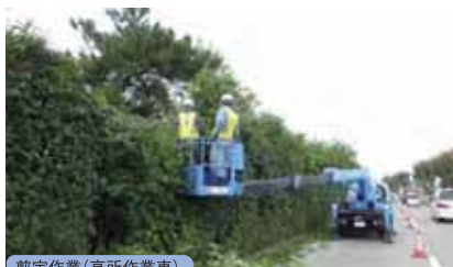
剪定作業(高所作業車)
