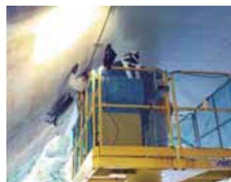
高所作業車を用いてトンネル壁面の 近接目視点検講習
