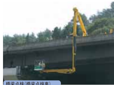
橋梁点検(橋梁点検車)
