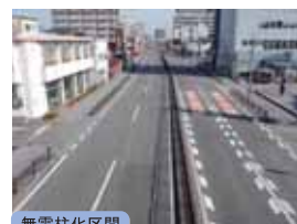
無電柱化区間
