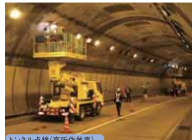
トンネル点検(高所作業車)
