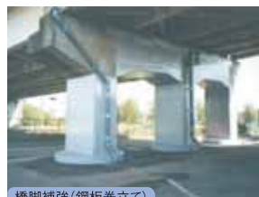
橋脚補強(銅板巻立て)
