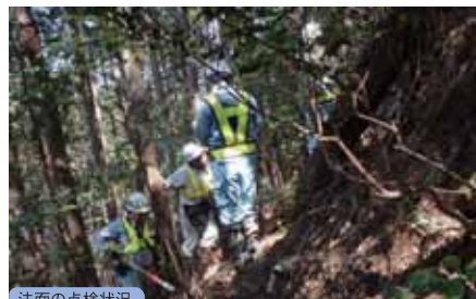
法面の点検状況
