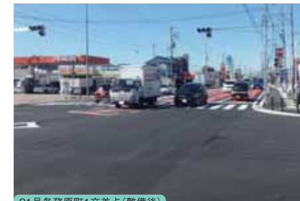
21号各務原町1交差点(整備後)
