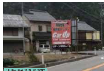
156号徳永歩道(整備前)
