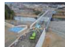
中津屋橋上部工を架けた様子
