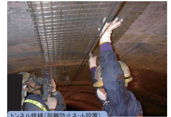
トンネル修繕(剥離防止ネット設置)
