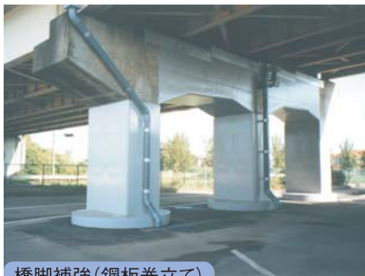
橋脚補強(鋼板巻立て)
