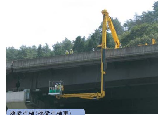
橋梁点検(橋梁点検車)
