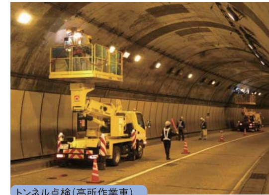
トンネル点検(高所作業車)
