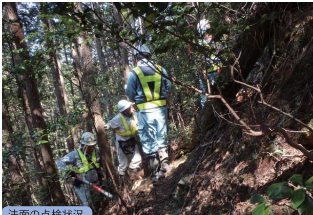
法面の点検状況
