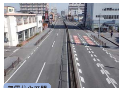
無電柱化区間
