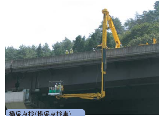
橋梁点検(橋梁点検車)
