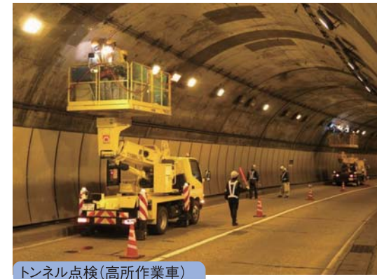
トンネル点検(高所作業車)
