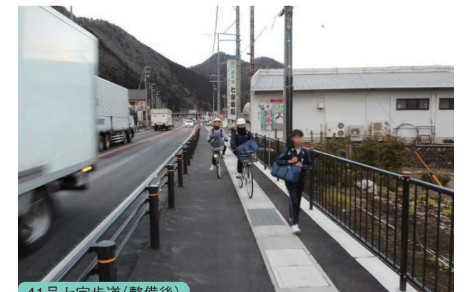
41号七宗歩道(整備後)
