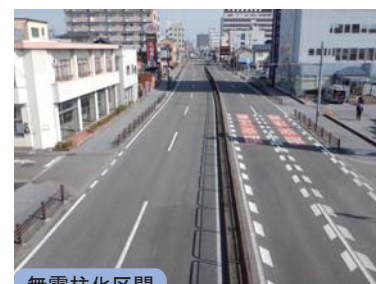
無電柱化区間
