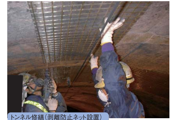
トンネル修繕(剥離防止ネット設置)
