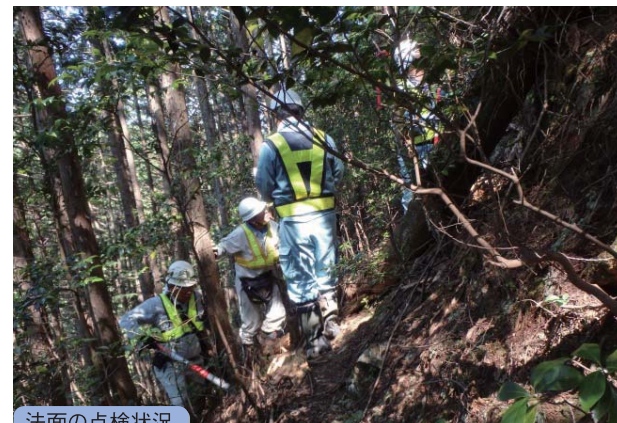
法面の点検状況
