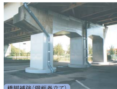
橋脚補強(鋼板巻立て)
