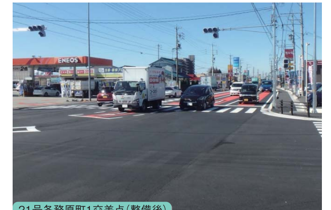
21号各務原町1交差点(整備後)
