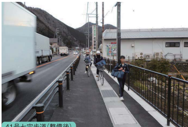
41号七宗歩道(整備後)
