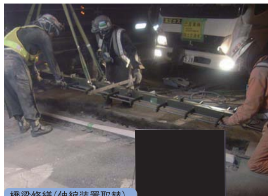
橋梁修繕(伸縮装置取替)
