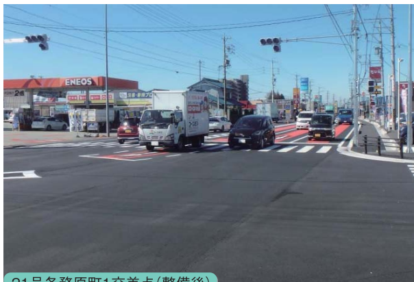
21号各務原町1交差点(整備後)
