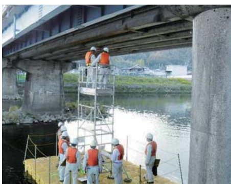
フロート台船+ローリングタワーの試乗体験 桁下等の診断講習
