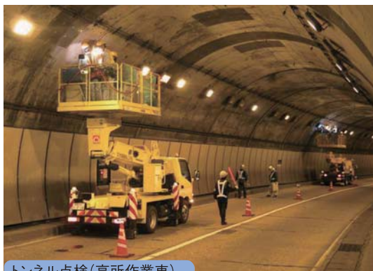
トンネル点検(高所作業車)
