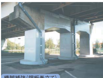
橋脚補強(鋼板巻立て)
