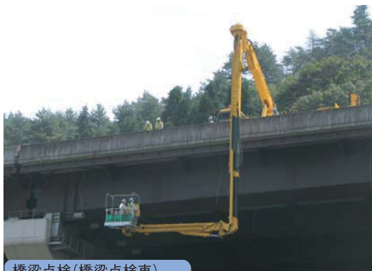
橋梁点検(橋梁点検車)
