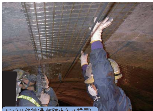
トンネル修繕(剥離防止ネット設置)
