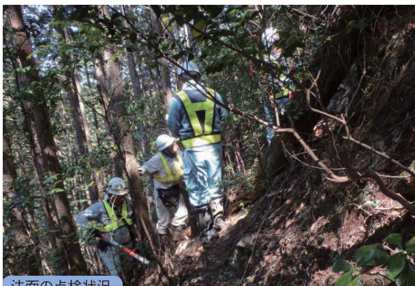
法面の点検状況
