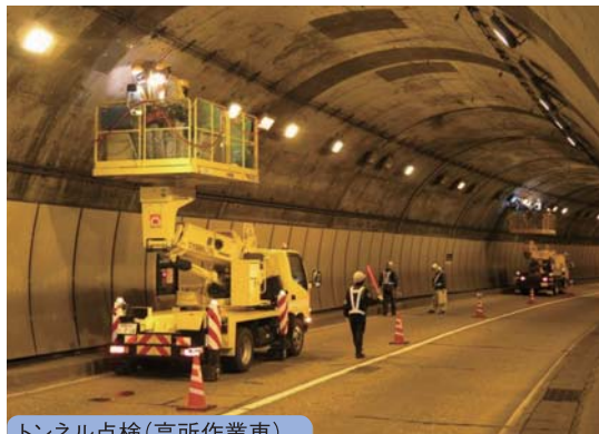
トンネル点検(高所作業車)
