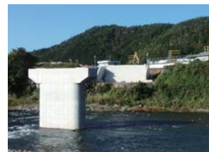
完成した中津屋橋下部工の様子
