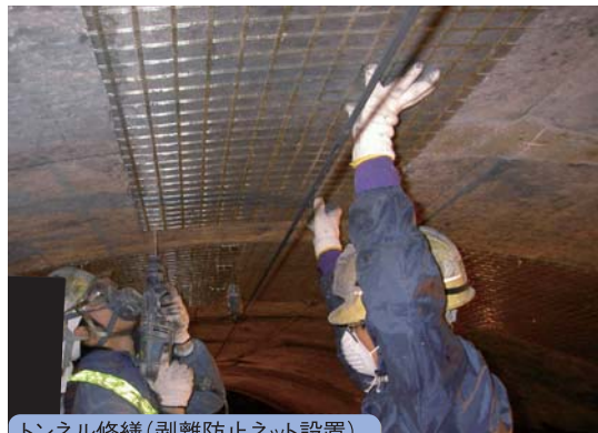
トンネル修繕(剥離防止ネット設置)
