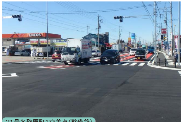
21号各務原町1交差点(整備後)
