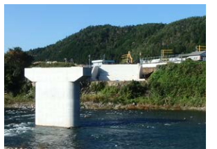
完成した中津屋橋下部工の様子
