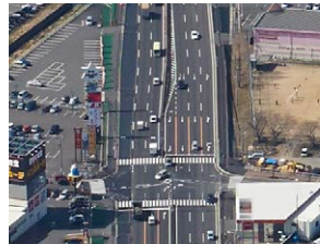
平成30年3月に穂積地区を一部6車線化しました。
