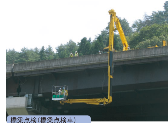
橋梁点検(橋梁点検車)
