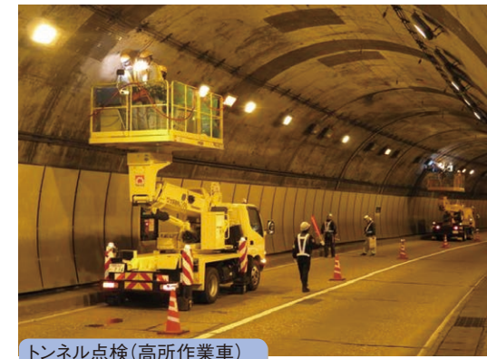
トンネル点検(高所作業車)
