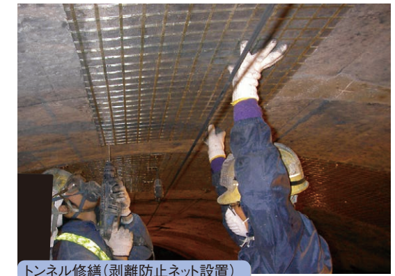
トンネル修繕(剥離防止ネット設置)
