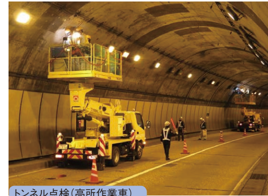
トンネル点検(高所作業車)
