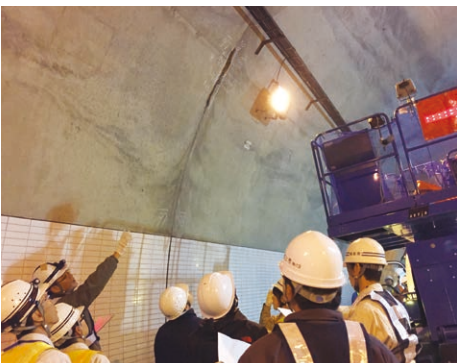
トンネル点検
