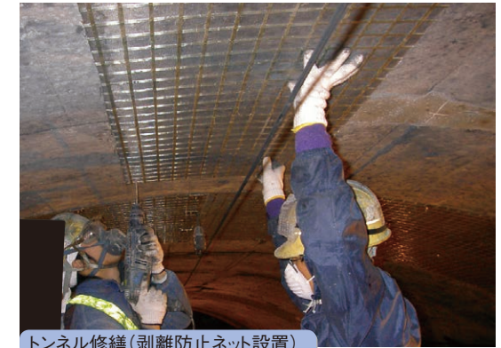
トンネル修繕(剥離防止ネット設置)
