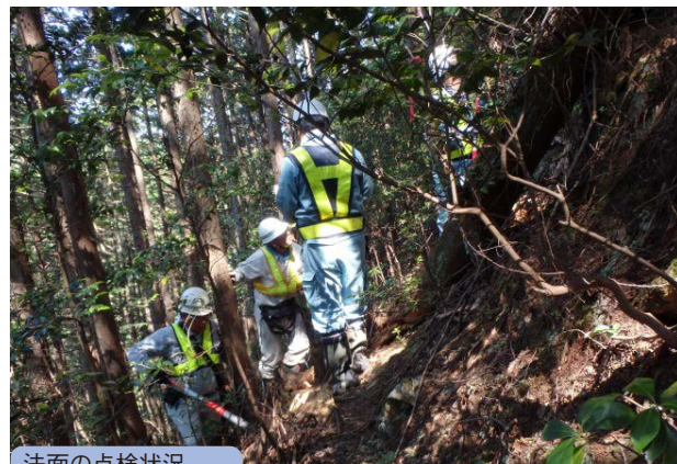
法面の点検状況
