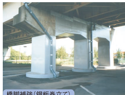
橋脚補強(銅板巻立て)
