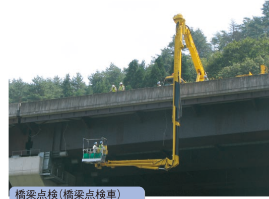
橋梁点検(橋梁点検車)
