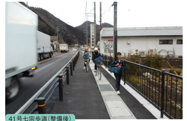
41号七宗歩道(整備後)
