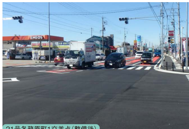
21号各務原町1交差点(整備後)
