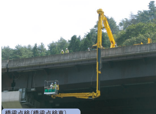
橋梁点検(橋梁点検車)
