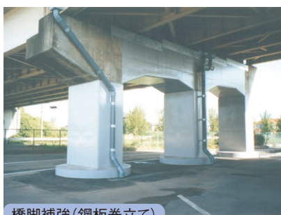
橋脚補強(鋼板巻立て)
