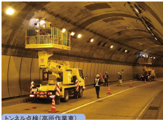
トンネル点検(高所作業車)
