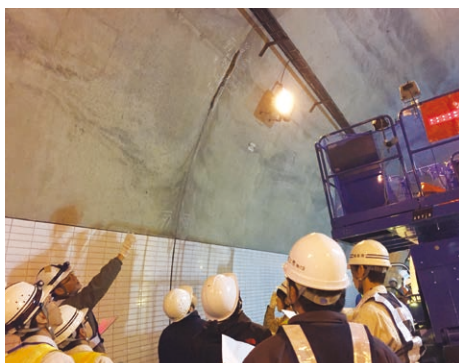
トンネル点検
