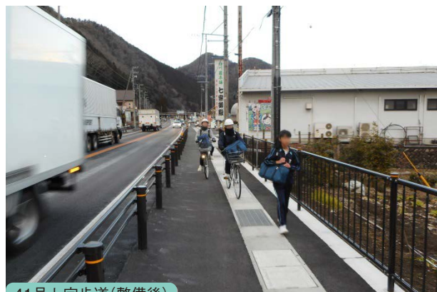
41号七宗歩道(整備後)
