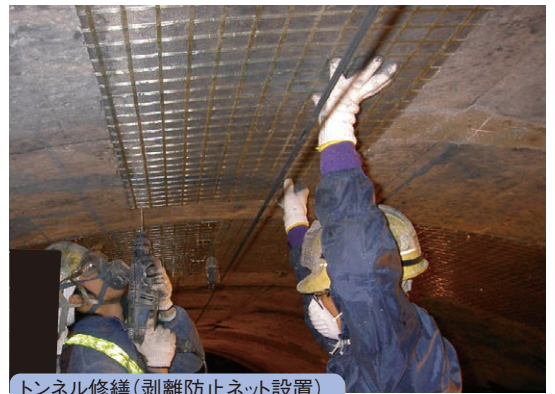
トンネル修繕(剥離防止ネット設置)
