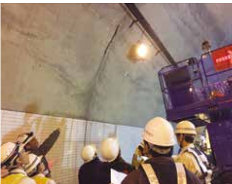
トンネル点検
