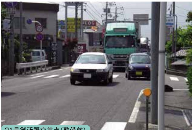
21号御所野交差点(整備前)
