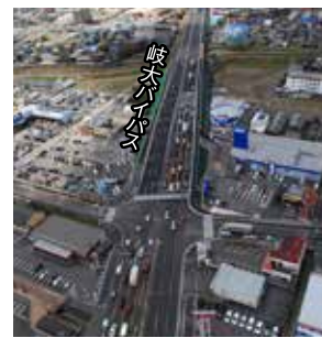
平成26年7月に瑞穂地区を一部6車線化しました。
