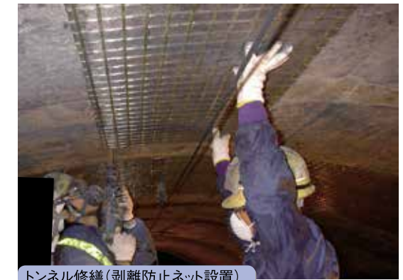
トンネル修繕(剥離防止ネット設置)
