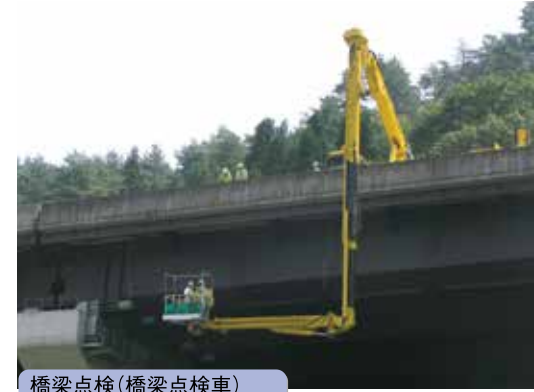
橋梁点検(橋梁点検車)
