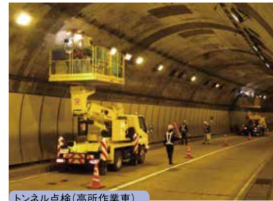
トンネル点検(高所作業車)
