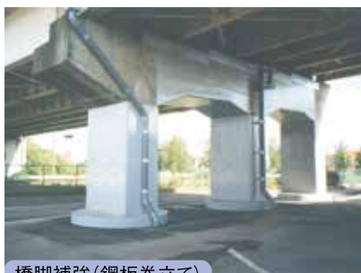
橋脚補強(鋼板巻立て)
