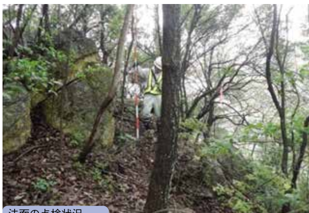
法面の点検状況
