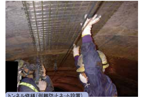
トンネル修繕(剥離防止ネット設置)
