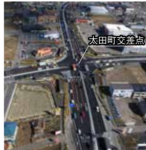
平成26年3月に太田町交差点部を拡幅しました。
