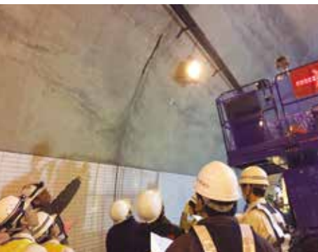
トンネル点検
