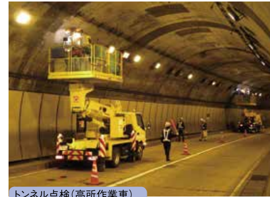
トンネル点検(高所作業車)
