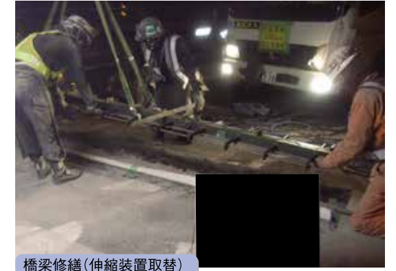
橋梁修繕(伸縮装置取替)
