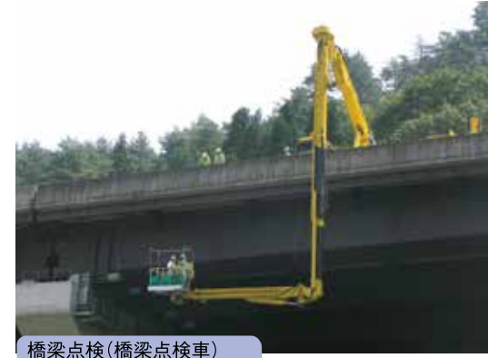
橋梁点検(橋梁点検車)
