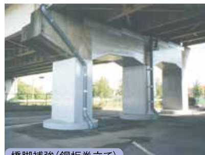
橋脚補強(鋼板巻立て)
