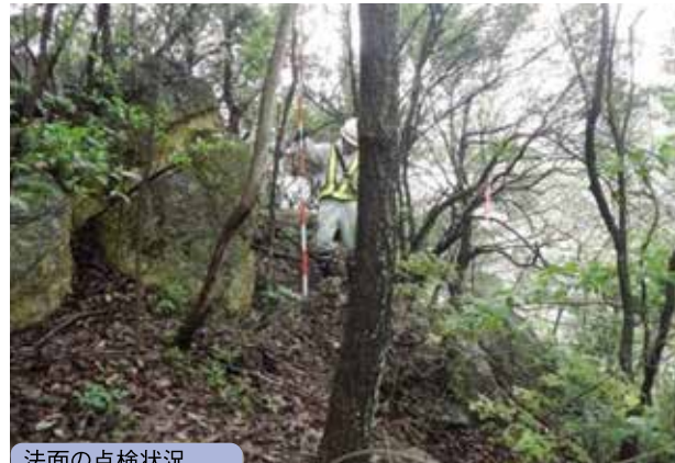
法面の点検状況
