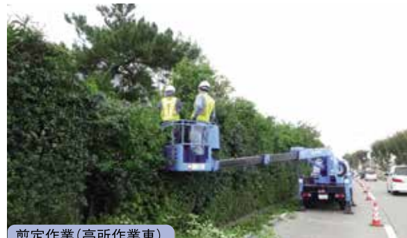
剪定作業(高所作業車)
