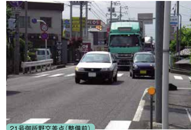
21号御所野交差点(整備前)
