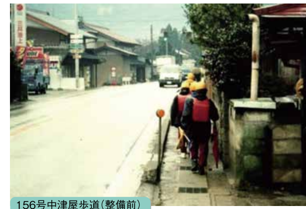
156号中津屋歩道(整備前)
