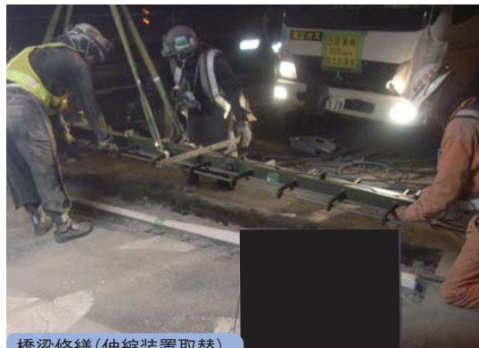
橋梁修繕(伸縮装置取替)
