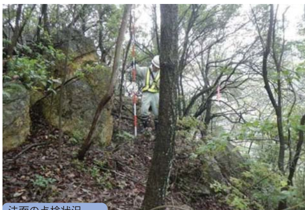
法面の点検状況
