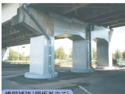
橋脚補強(鋼板巻立て)
