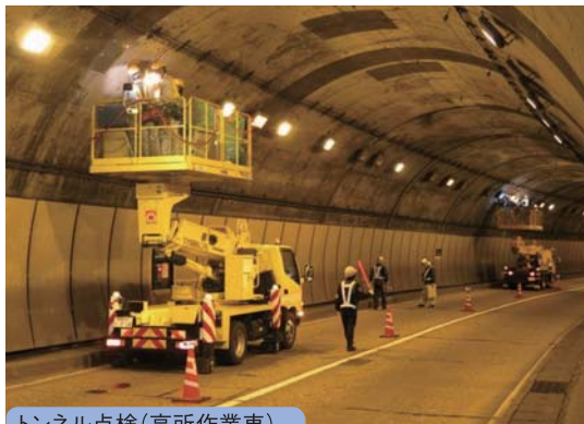
トンネル点検(高所作業車)
