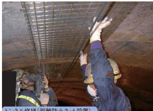
トンネル修繕(剥離防止ネット設置)
