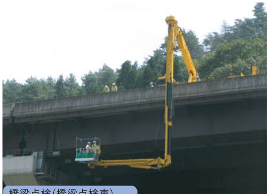
橋梁点検(橋梁点検車)
