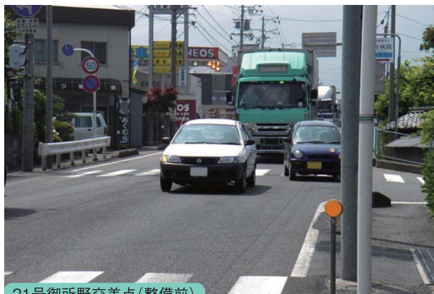
21号御所野交差点(整備前)
