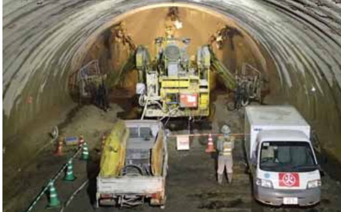
1. 掘進が進む三輪トンネル(仮称)(岐阜市北野北地内) H27.12撮影
