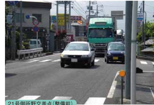
21号御所野交差点(整備前)
