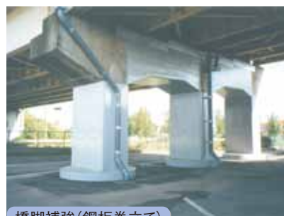
橋脚補強(銅板巻立て)
