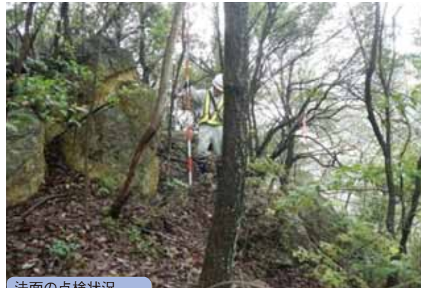
法面の点検状況
