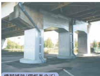
橋脚補強(鋼板巻立て)
