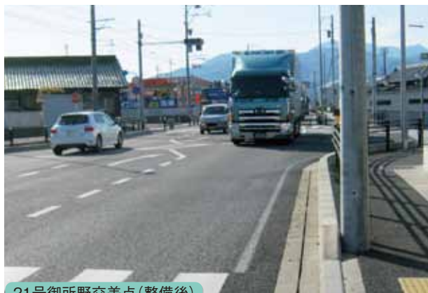
21号御所野交差点(整備後)
