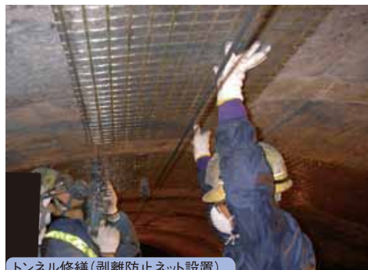
トンネル修繕(剥離防止ネット設置)
