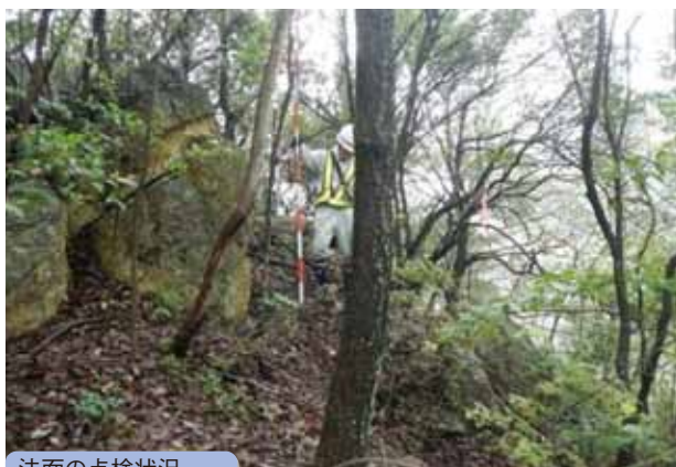
法面の点検状況
