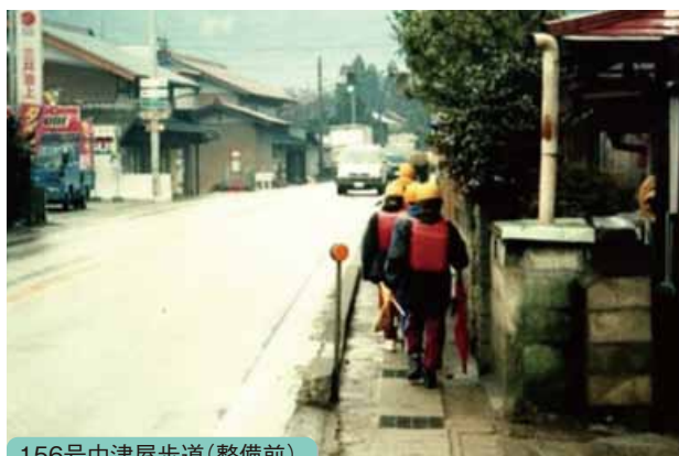
156号中津屋歩道(整備前)
