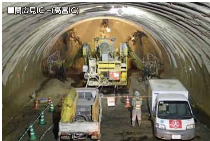
1. 掘進が進む三輪トンネル(仮称)(岐阜市北野北地内)
