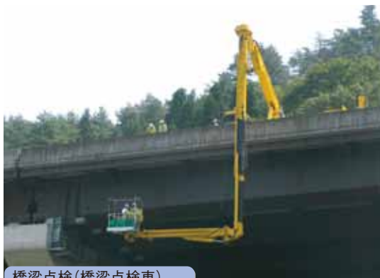
橋梁点検(橋梁点検車)
