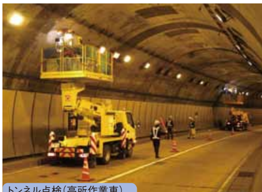
トンネル点検(高所作業車)
