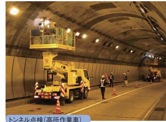
トンネル点検(高所作業車)
