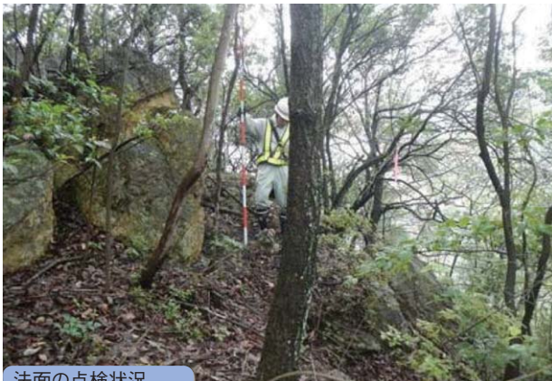
法面の点検状況
