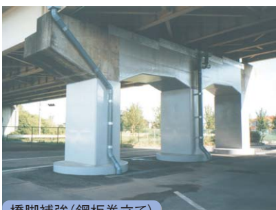
橋脚補強(鋼板巻立て)
