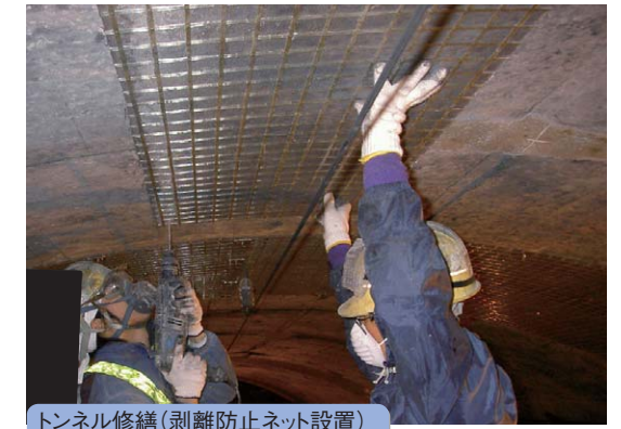
トンネル修繕(剥離防止ネット設置)
