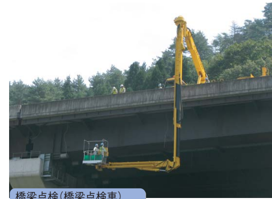
橋梁点検(橋梁点検車)
