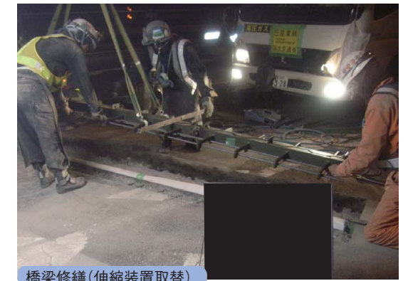
橋梁修繕(伸縮装置取替)
