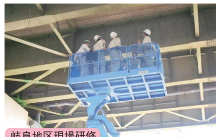
岐阜地区現場研修
