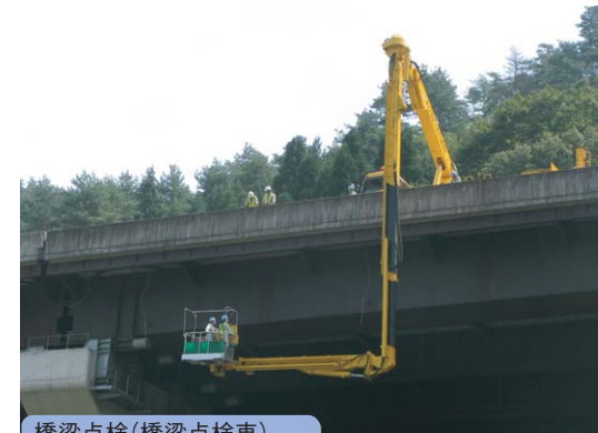
橋梁点検(橋梁点検車)
