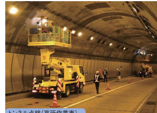
トンネル点検(高所作業車)
