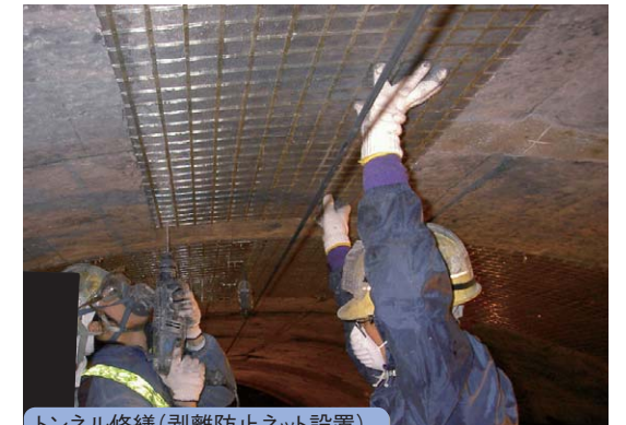
トンネル修繕(剥離防止ネット設置)
