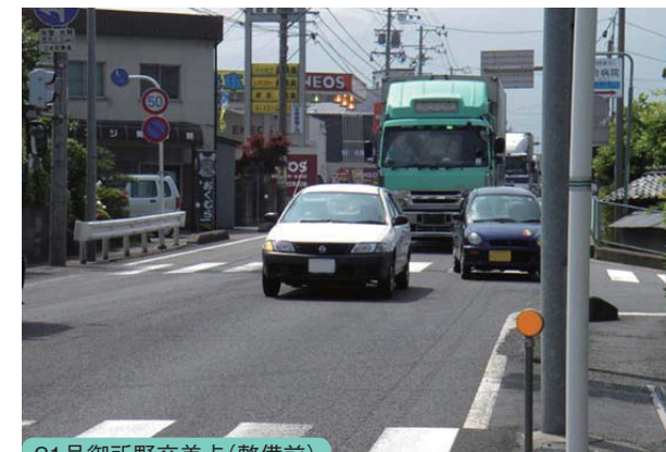
21号御所野交差点(整備前)
