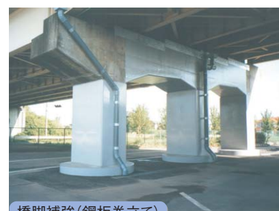
橋脚補強(鋼板巻立て)
