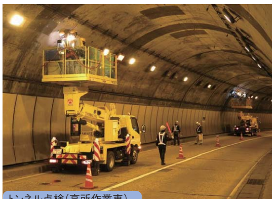
トンネル点検(高所作業車)
