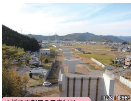
4. 橋梁下部工の工事状況 【岐阜県山県市東深瀬地内】
