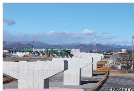
8. 橋梁下部工の工事状況 【岐阜県神戸町瀬古地内】
