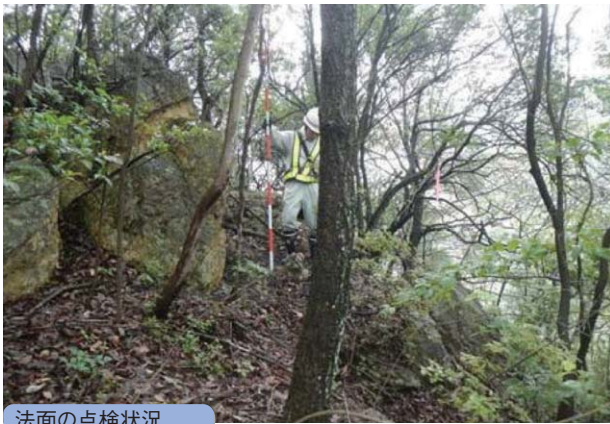
法面の点検状況
