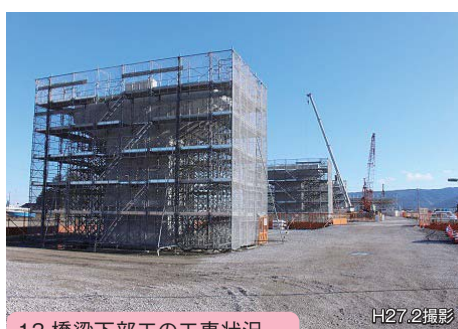
13. 橋梁下部工の工事状況 【岐阜県養老町口ヶ島地内】
