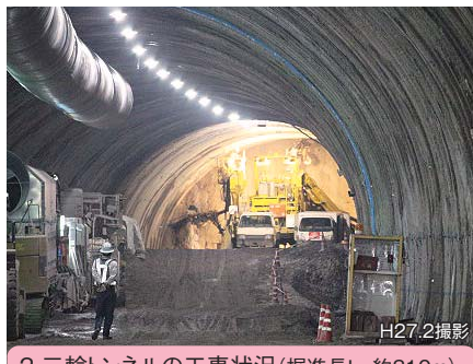
2. 三輪トンネルの工事状況(掘進長L=約310m) 【岐阜県岐阜市北野北地内】
