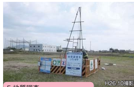
5. 地質調査 【岐阜県岐阜市大学北地内】
