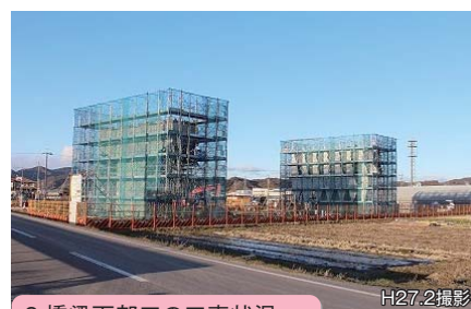
6. 橋梁下部工の工事状況 【岐阜県本巣市見延地内】
