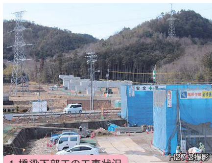
1. 橋梁下部工の工事状況 【岐阜県関市広見地内】
