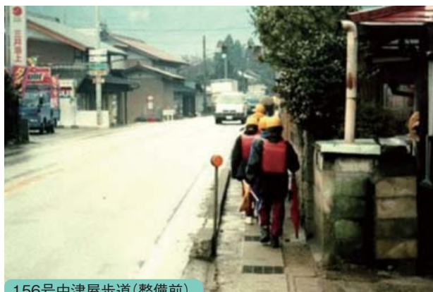
156号中津屋歩道(整備前)
