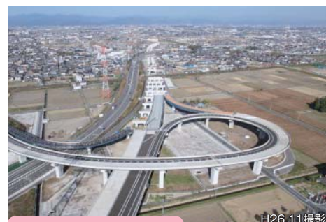
10. 大垣西ICの工事状況 【岐阜県大垣市松地内】
