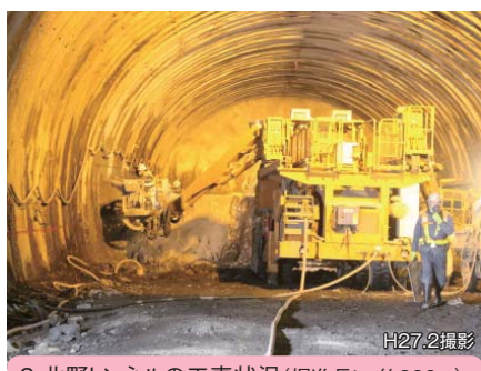
3. 北野トンネルの工事状況(掘進長L=約300m) 【岐阜県岐阜市北野北地内】
