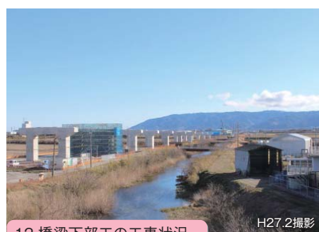
12. 橋梁下部工の工事状況 【岐阜県養老町高田地内】
