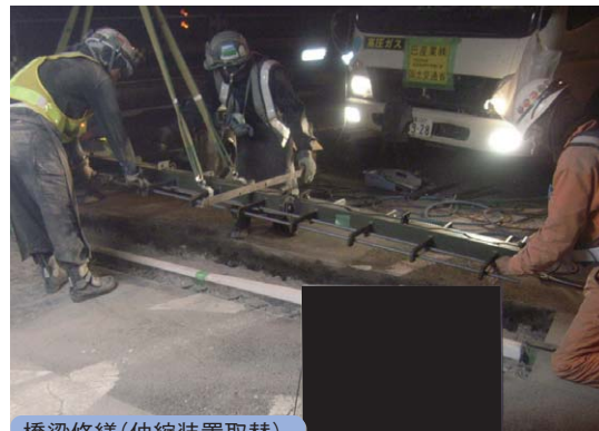
橋梁修繕(伸縮装置取替)
