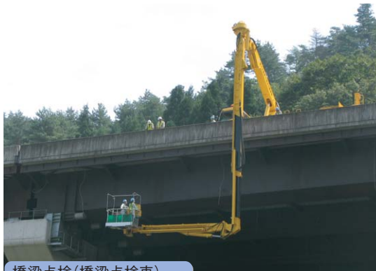
橋梁点検(橋梁点検車)
