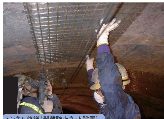
トンネル修繕(剥離防止ネット設置)
