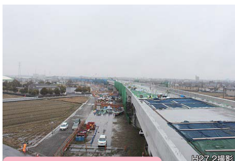
9. 橋梁上部工の工事状況 【岐阜県大垣市興福地町地内】
