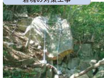
岩塊の対策工事
