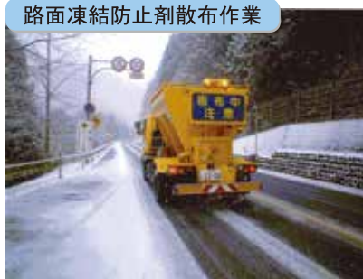
路面凍結防止剤散布作業
