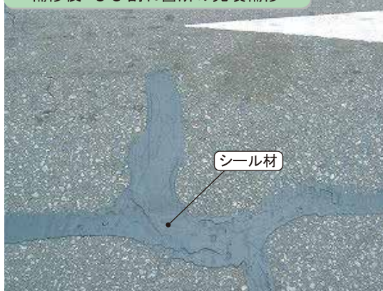
補修後 ひび割れ箇所の充填補修
