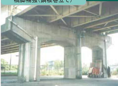
橋脚補強(鋼板巻立て)
