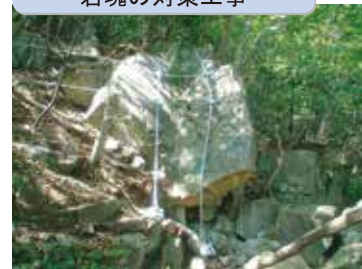
岩塊の対策工事
