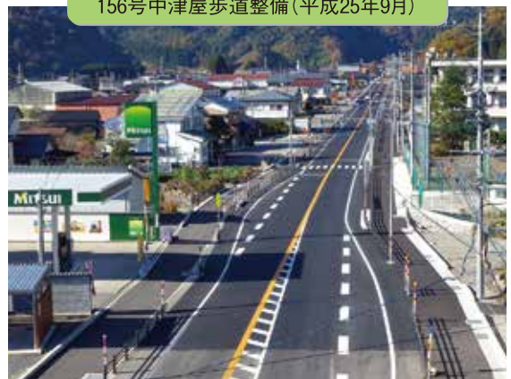
156号中津屋歩道整備(平成25年9月)
