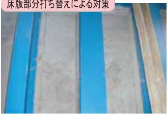
床版部分打ち替えによる対策
