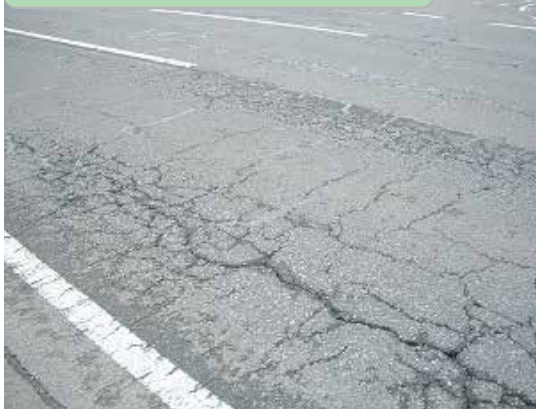
補修前 路面に亀甲状のひび割れ発生
