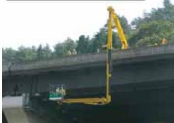
橋梁点検車による定期点検
