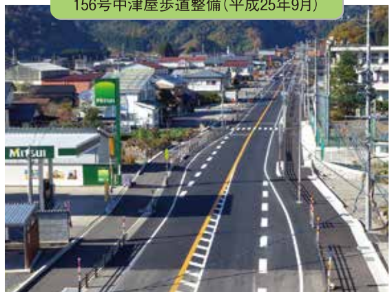
156号中津屋歩道整備(平成25年9月)
