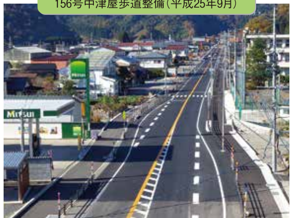
156号中津屋歩道整備(平成25年9月)
