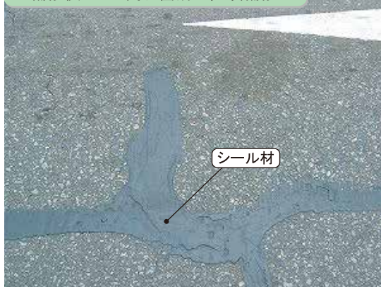
補修後 ひび割れ箇所の充填補修
