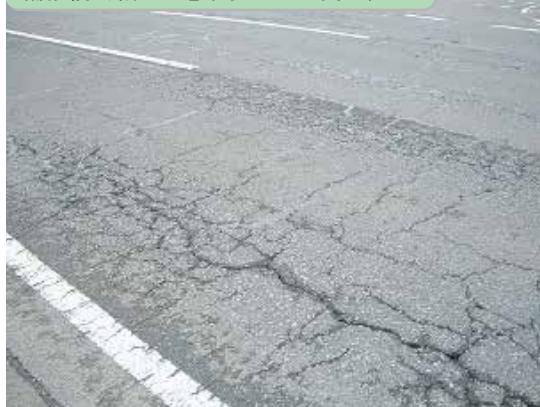
補修前 路面に亀甲状のひび割れ発生
