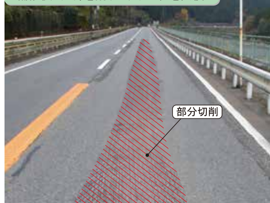
補修後 凸部を削りとり平坦性を回復
