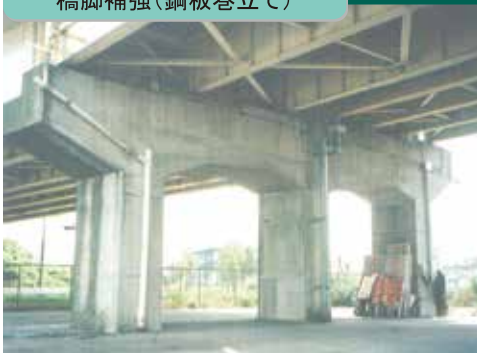
橋脚補強(鋼板巻立て)
