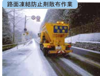
路面凍結防止剤散布作業
