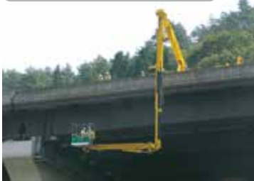
橋梁点検車による定期点検
