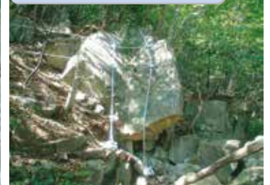
岩塊の対策工事
