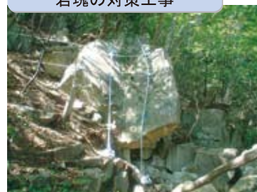
岩塊の対策工事
