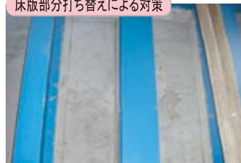
床版部分打ち替えによる対策
