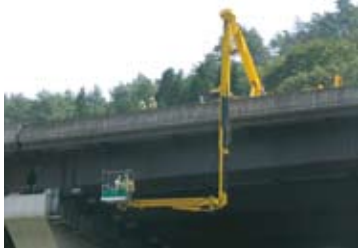
橋梁点検車による定期点検
