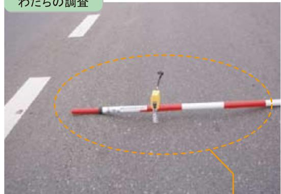
補修前 路面横断方向にわだち掘れ発生
