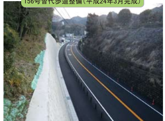
156号曾代歩道整備(平成24年3月完成)
