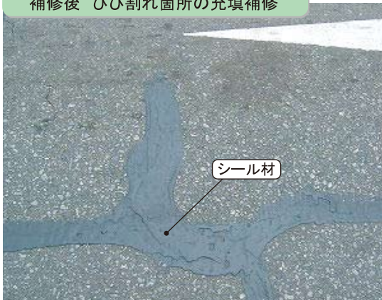
補修後 ひび割れ箇所の充填補修
