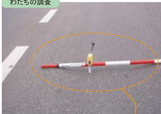
わだちの調査
