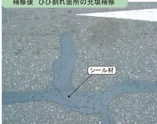
補修後 ひび割れ箇所の充填補修
