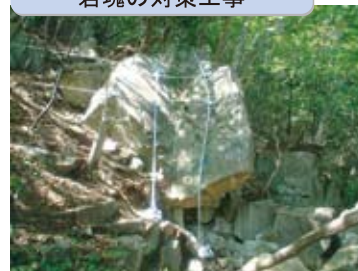
岩塊の対策工事
