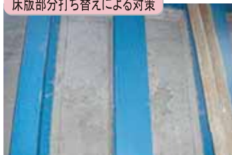
床版部分打ち替えによる対策
