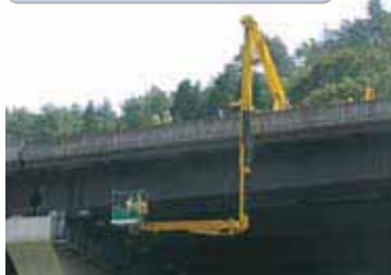
橋梁点検車による定期点検
