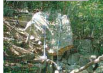
岩塊の対策工事
