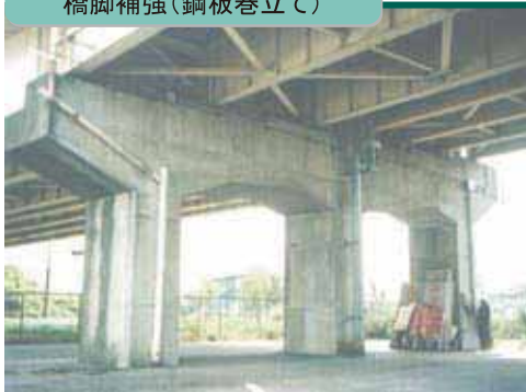
橋脚補強(鋼板巻立て)
