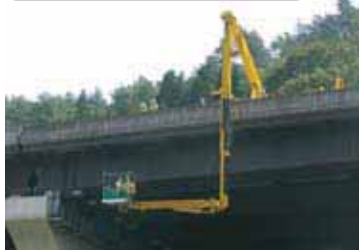
橋梁点検車による定期点検
