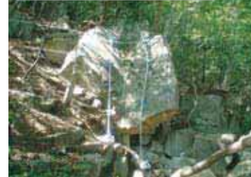
岩塊の対策工事
