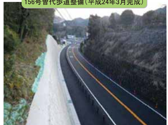
156号曾代歩道整備(平成24年3月完成)
