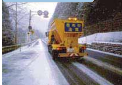
路面凍結防止剤散布作業
