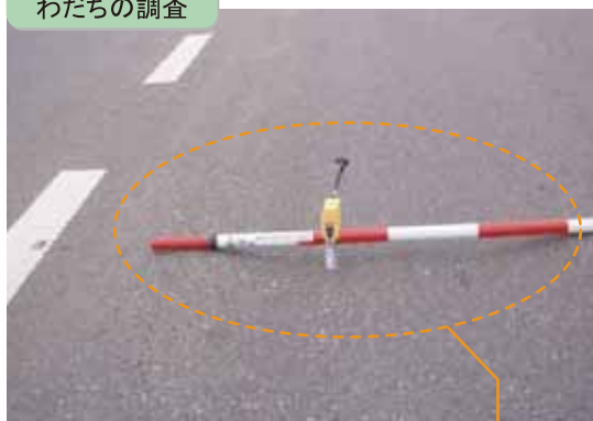
わだちの調査
