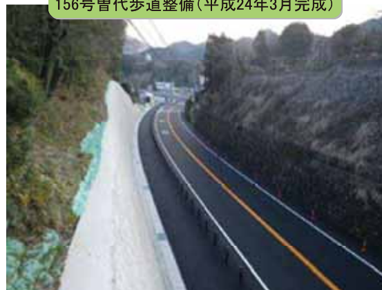
156号曾代歩道整備(平成24年3月完成)
