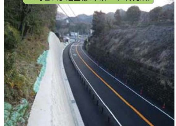
156号曾代歩道整備(平成24年3月完成)
