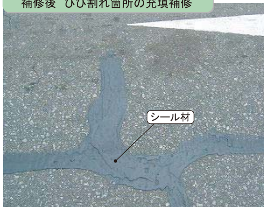
補修後 ひび割れ箇所の充填補修
