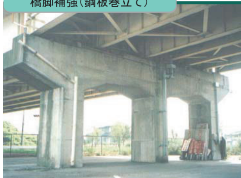
橋脚補強(鋼板巻立て)
